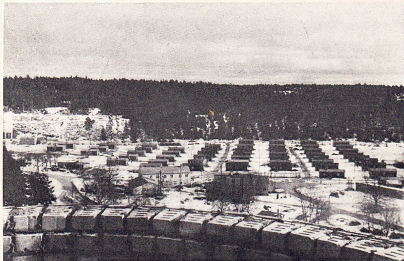
Den första nybyggartidens baracker sedda från fabriken skorstensbygge. Gläntan i skogen till vänster på bilden är det avröjda kalkberget.
