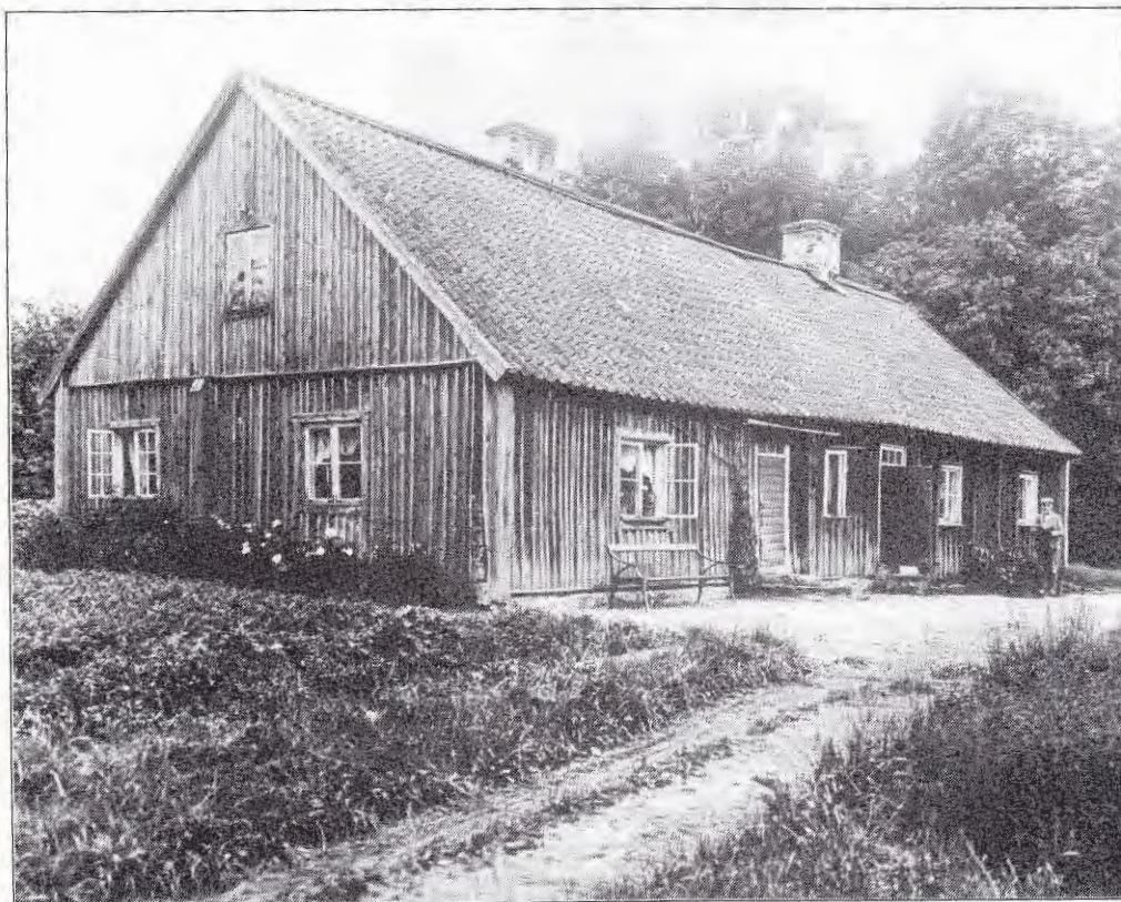
Gamla trädgårdsbyggnaden riven 1931. Tjänade som bostad åt gårdsfolket, bland annat trädgårdsmästaren och skollärarinnan. Troligen uppförd strax efter 1719.
